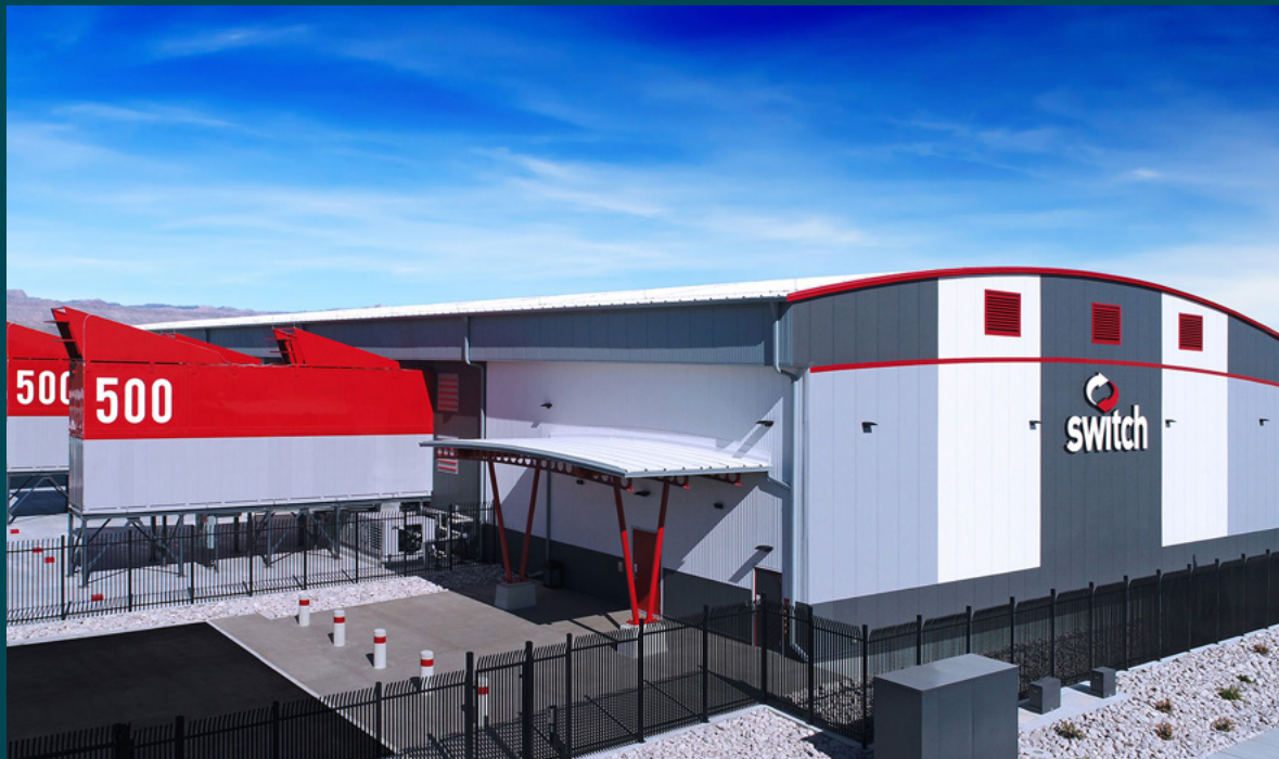
Switch LAS VEGAS 12 Data Center
