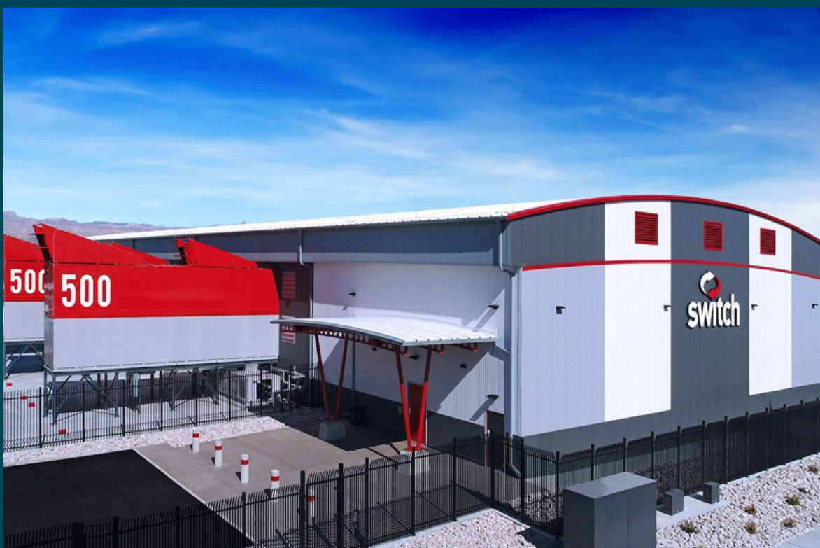
スイッチ LAS VEGAS 12 Data Center
